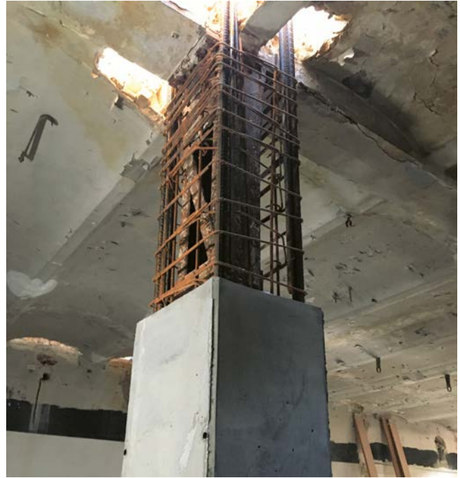
Bild 13 Vorhandene Stahlstützen im Untergeschoss wurden zum Lastabtrag aus den neuen Geschossen verstärkt
